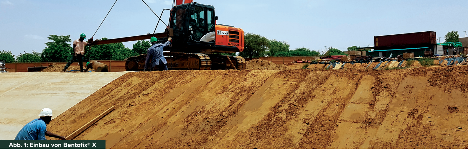
Abb. 1: Einbau von Bentofix® X
